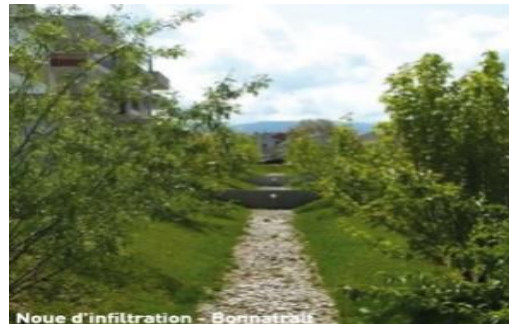
Noue d'infiltration : SYMASOL (2016)
