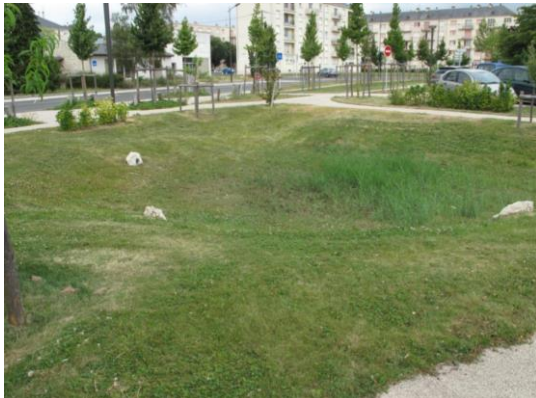
Bassin d'infiltration : Tedoldi (2017)
